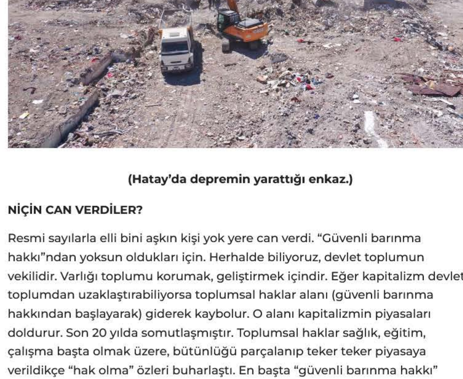
(Hatay'da depremin yarattığı enkaz.)
